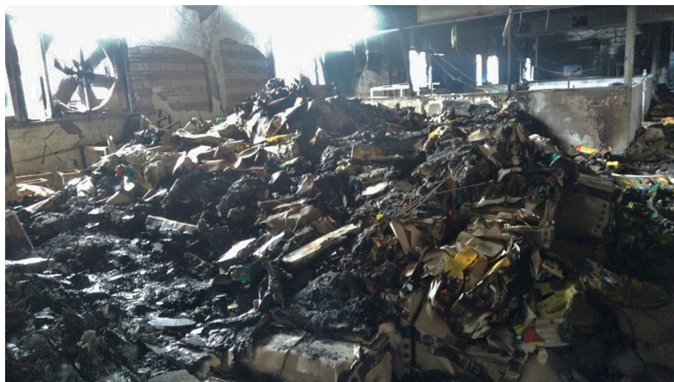
Les dégâts après un incendie important dans un atelier de peinture à Winson, qui s'est produit en mai 2015. L'atelier fabriquait le jouet Mattel « Rock 'Em Sock 'Em ».
