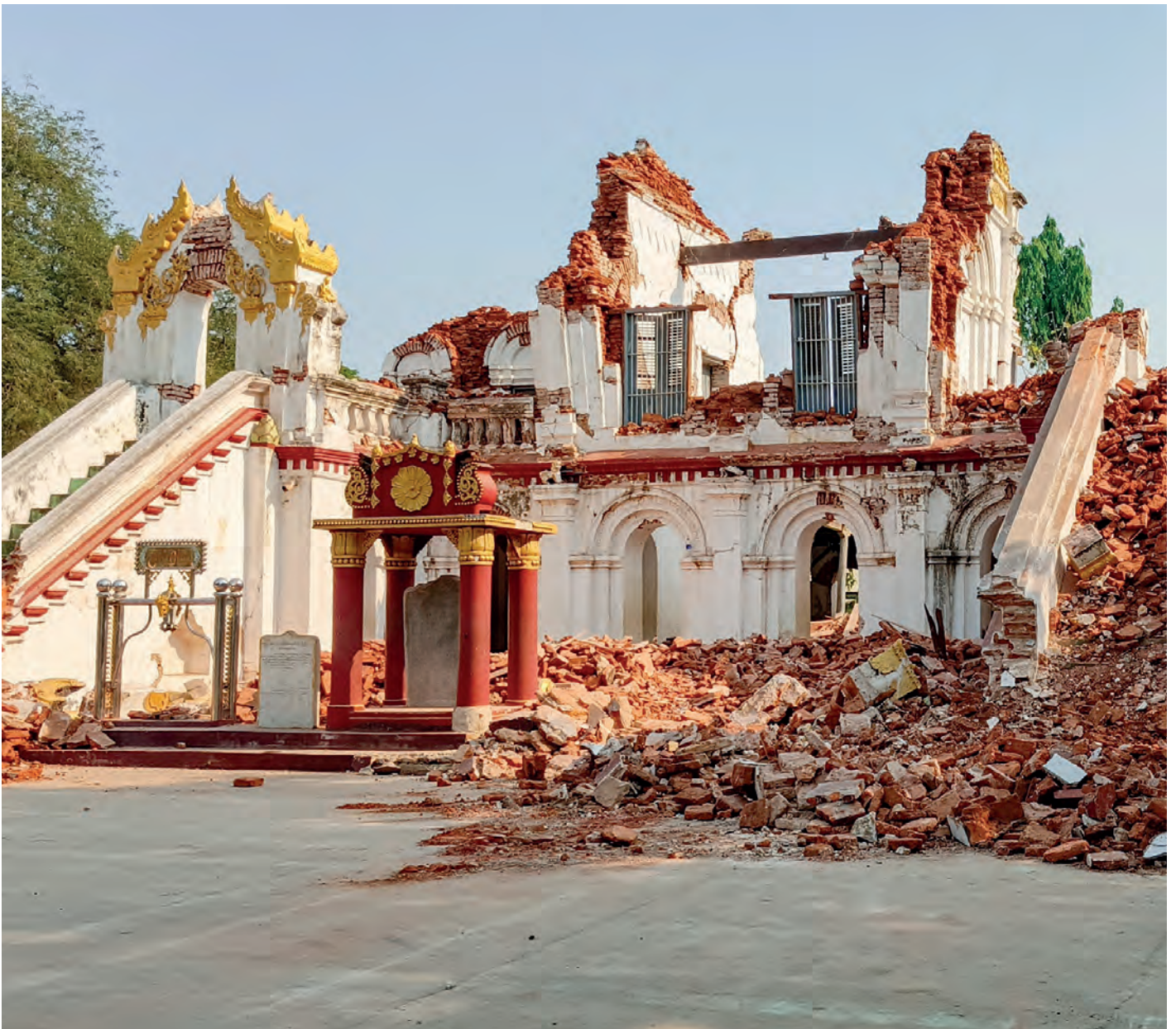
Beim schweren Erdbeben im März 2025 wurden in Myanmar viele Häuser vollständig oder teilweise zerstört.
