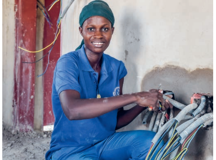
Yvette Tapsoba relie une maison au réseau électrique.
